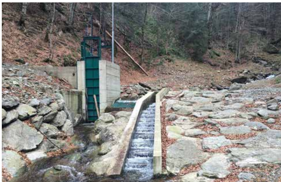
Figura 12 - Scară de pești tehnică la MHC (Aquainvest).
