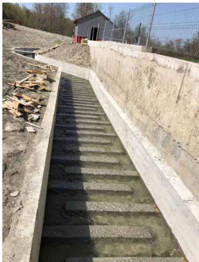
Figura 10 – Pasaj tip by-pass puternic geometrizat la MHC pentru a asigura mobilitate speciei Cottus Gobio (AquaInvest). 9
